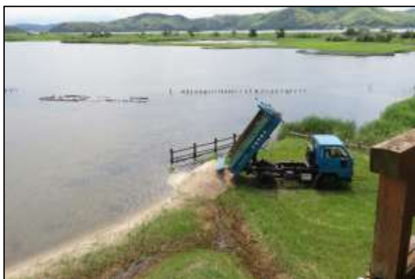
写真 16 ネイチャーセンター前に砂を搬入 (2020年7月25日)
