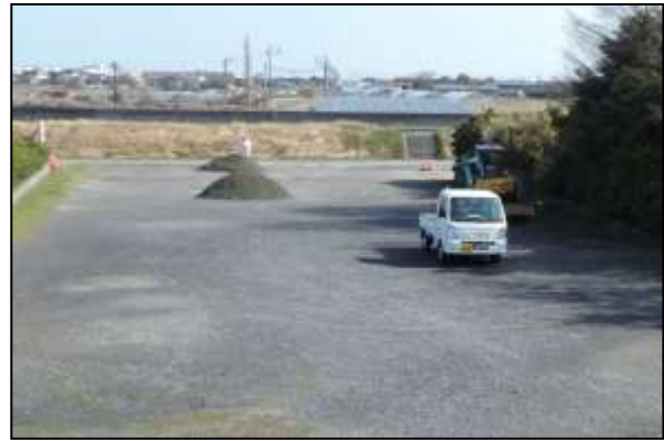
写真 21 正門横駐車場の地ならし工事 (2021年3月22日)
