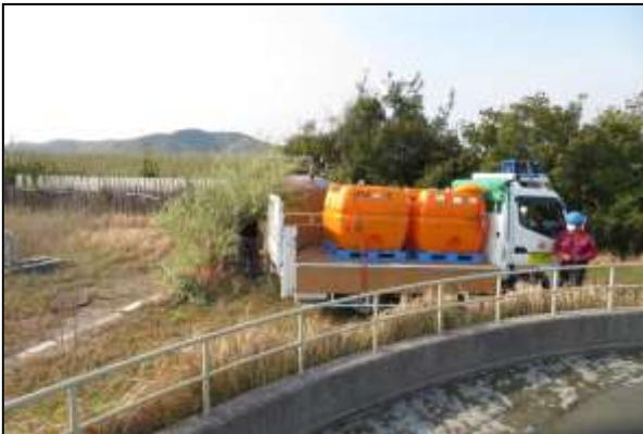
写真10 水系生態循環回復システムに凝集剤を補充(2020年4月17日)
