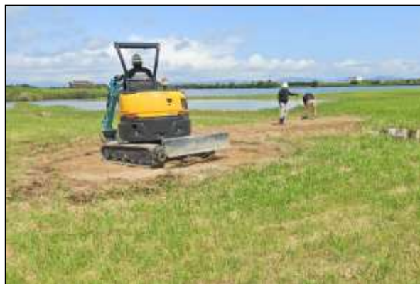
写真 15 保護区内の島を陸続きにする 埋め立て工事(2020年7月18日)
