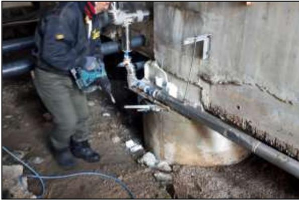
写真7 破裂した水道管の修繕と凍結防止工事
