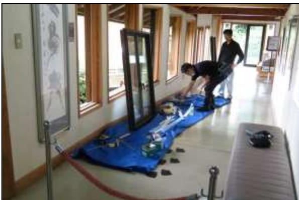
写真5 視聴覚室前廊下の窓のアルミサッシ工事
