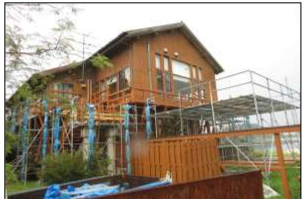
写真6 2階のキャットウォーク修繕工事
