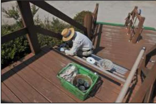
写真1 玄関前階段のすべり止めテープ貼り換え
