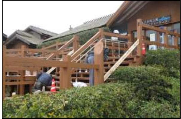
写真8 正面玄関前階段の手すりの修繕
