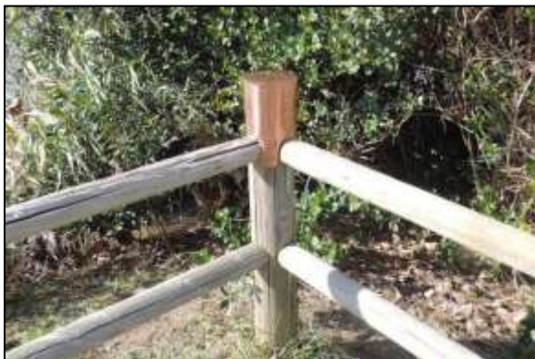
写真 15 彦名東橋横の広場の柵の修繕 (2021年12月3日)
