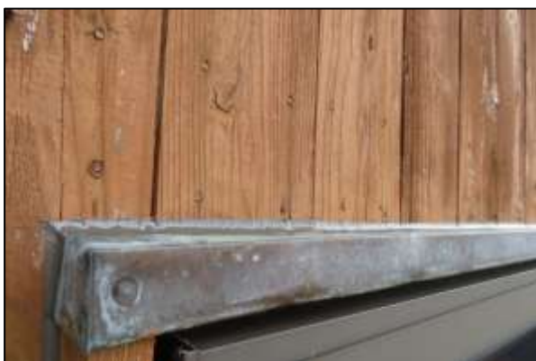
写真5 展望ホール窓枠に雨漏り防止 コーキング(2021年12月2日)
