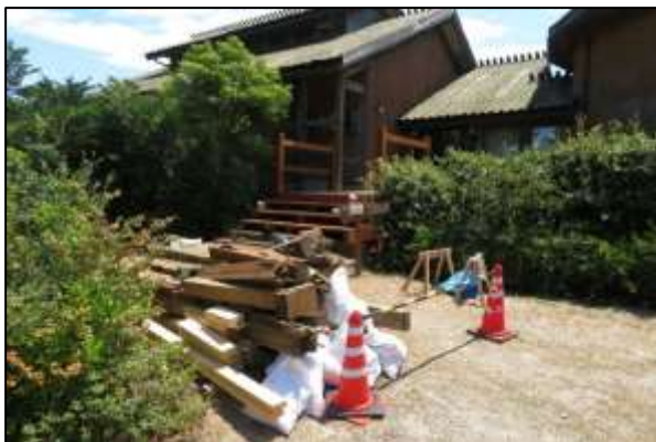
写真1 展示ホール横の非常口前階段の修繕 (2021年8月6日)
