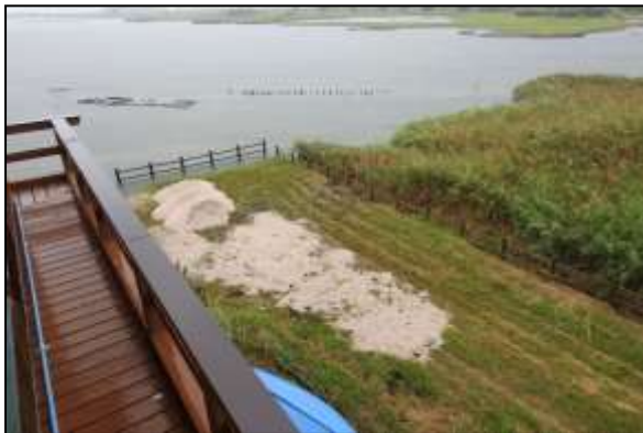
写真 13 ネイチャーセンター前の岸辺を埋め戻すための砂を搬入 (2021年9月22日)
