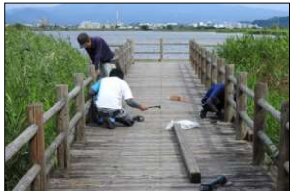
写真10 水鳥観察棧橋の修繕(2021年6月3日)
