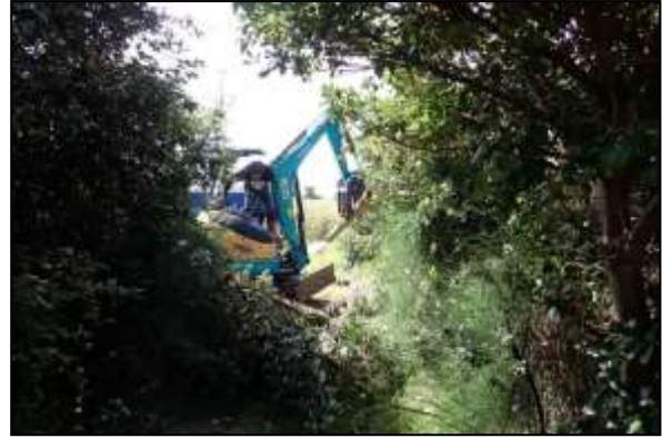
写真 12 台風で倒れた木の撤去 (2021年9月21日)
