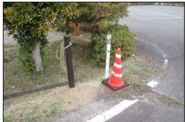
写真 16 第1駐車場のバリケード支柱の修繕 (2022年3月24日)
