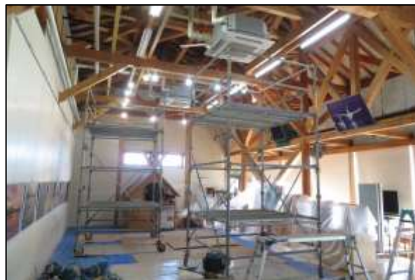
写真2 観察ホールのエアコン設置工事 (2021年8月28日)
