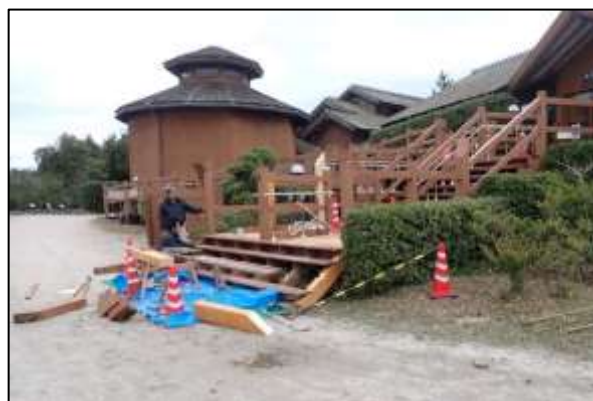
写真6 正面玄関前階段の修繕 (2022年3月26日)
