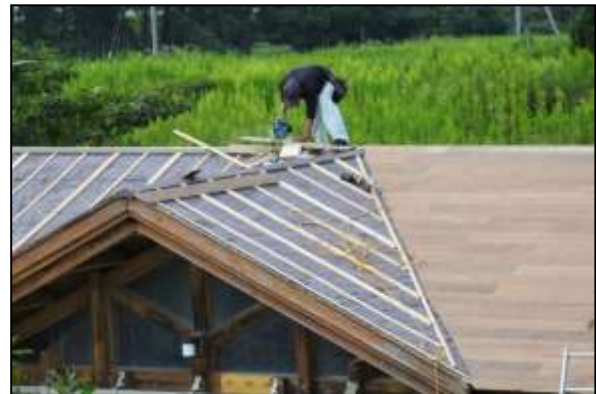
写真 14 屋外倉庫の屋根の修繕 (2021年9月23日)
