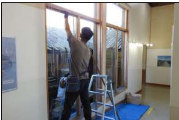
写真3 スロープの窓のアルミサッシ工事 (2021年10月11日)
